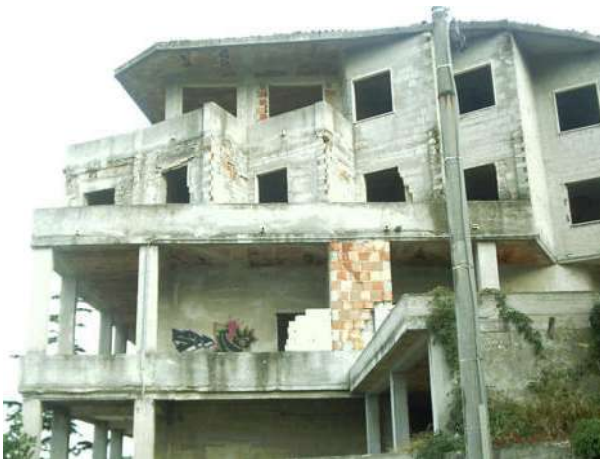
SITUAZIONE ANTE INTERVENTO
