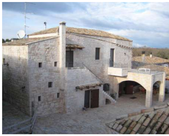
SITUAZIONE POST INTERVENTO
