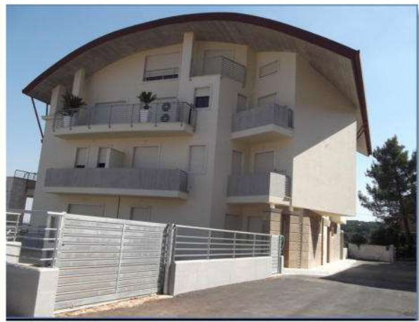
SITUAZIONE POST INTERVENTO
